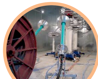
Испытательная станция Haefely до 350 кВ
