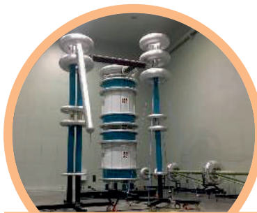
Испытательная станция Highvolt до 750 кВ
